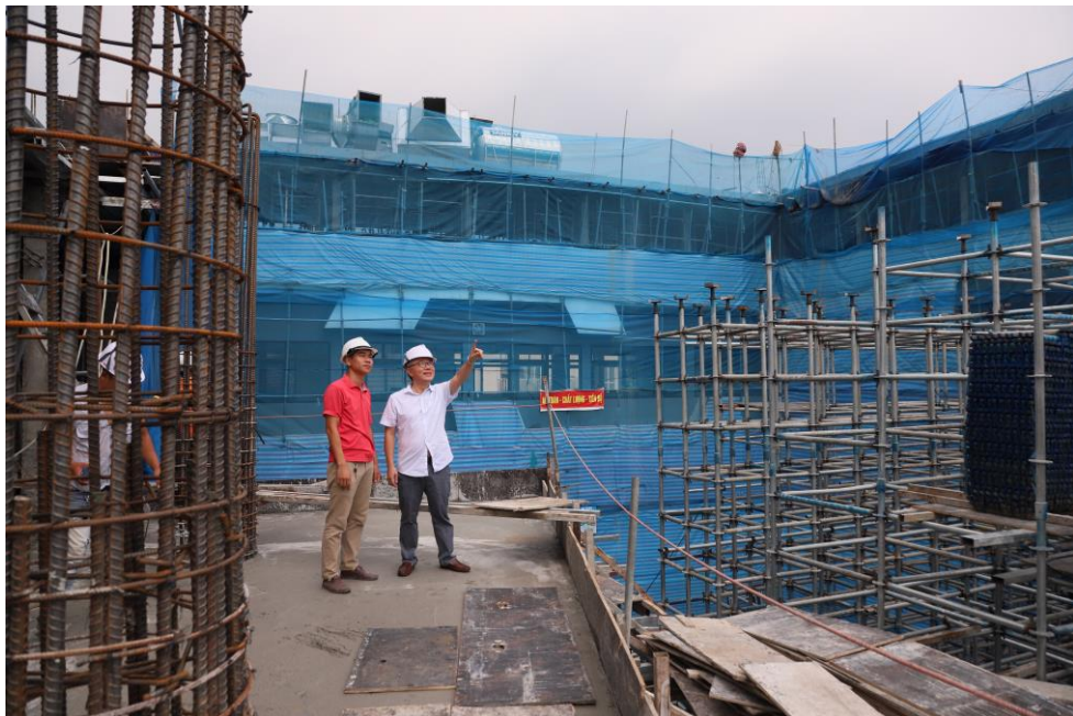
GS. Ngô Bảo Châu đến thăm công trình trụ sở VNCCCT Prof. Ngo Bao Chau at the construction site of VIASM Building
